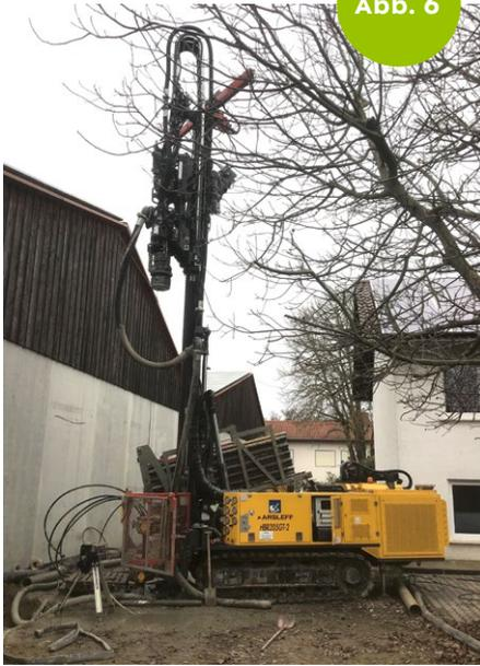
Bohrgerät zur Durchführung von Tiefenbohrungen Foto: Weingut Schreiber-Kiebler
